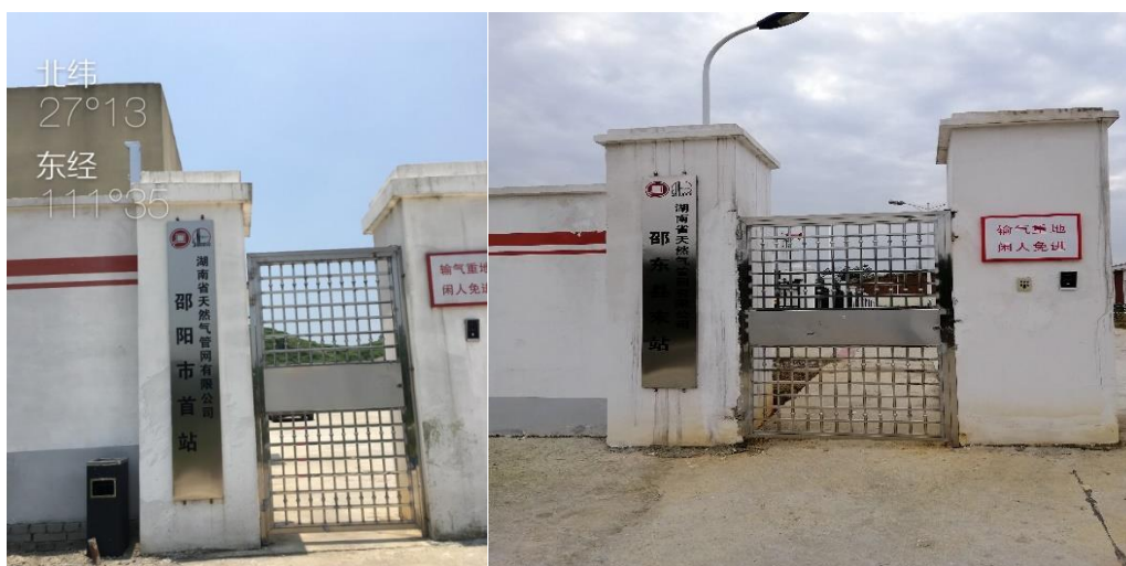
图：邵阳市-邵阳县、邵阳市-邵东市输气管道-邵阳市首站
